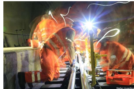
Unterhalt der Bahnanlagen parallel zum Bau
