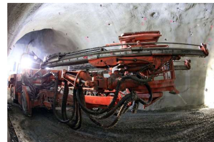
Sprengungen in 15' min. Zugspausen
