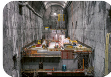
Linthal 2015 (Kraftwerk: Tiefbau)
