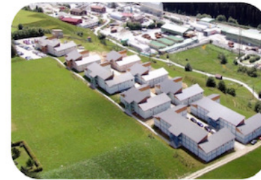
NEAT Sedrun (Tunnel: Tiefbau)
