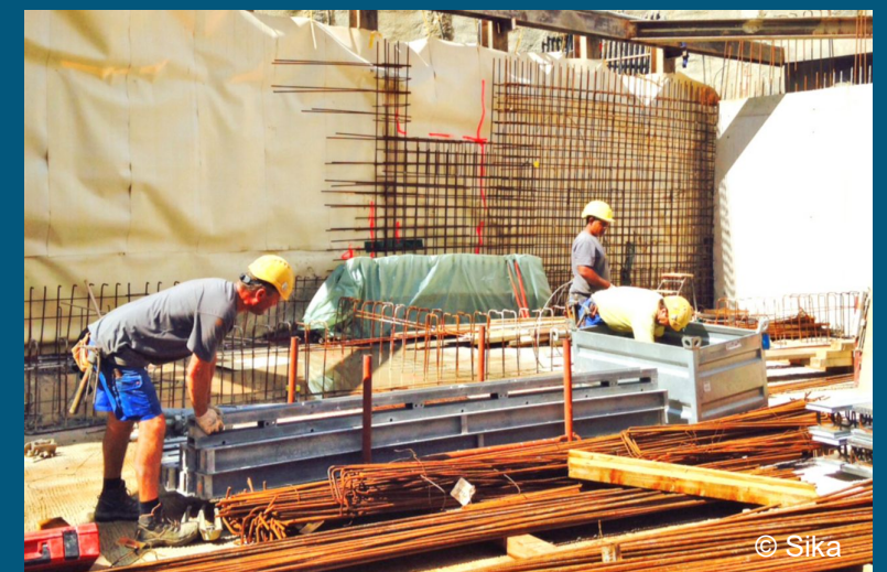
Abdichtung Gebäudekeller Spital Bethanien
